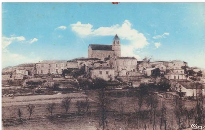
St-Paul-Labouffie. Vue générale Sud-Ouest
